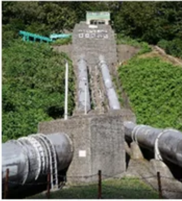
供給元:末沢発電所(Jパワー)
